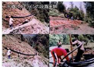
▲HICバンプラインの敷設により、はじめて水道が引かれた村は多い
