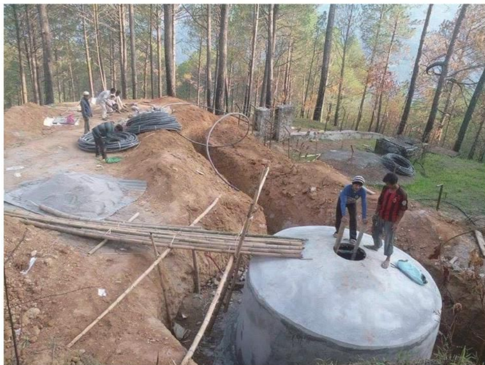
水源近くの老朽化した貯水タンクを復旧
