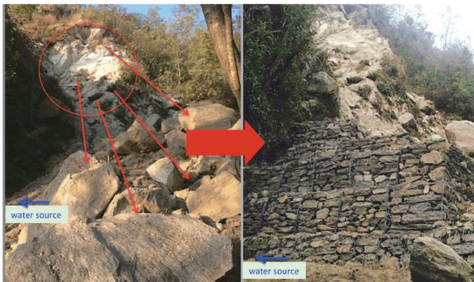
地震の土砂崩れにより埋没した水源を掘り起こし、崖崩れの再発防止用工事を実施
