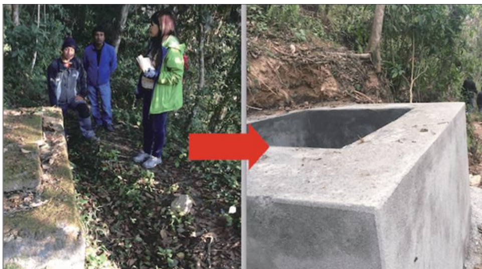
水源近くの老朽化した貯水タンクを復旧
