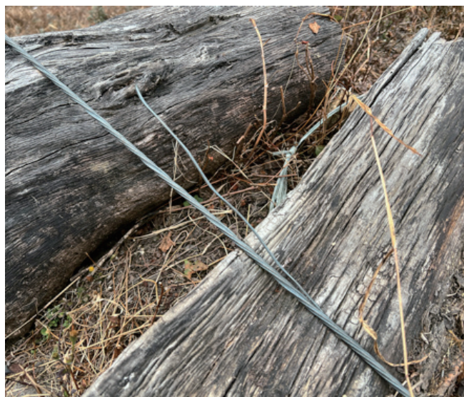
結束ワイヤーに破断がみられ、現在は修復が必要な状態になっている。
