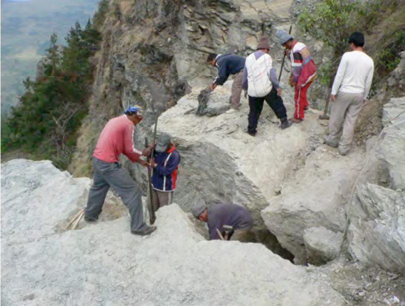
崖崩れ現場で対策工事をする村人 崖崩れをこのまま放置すると大災害になります。対策工事がいそがれます。
